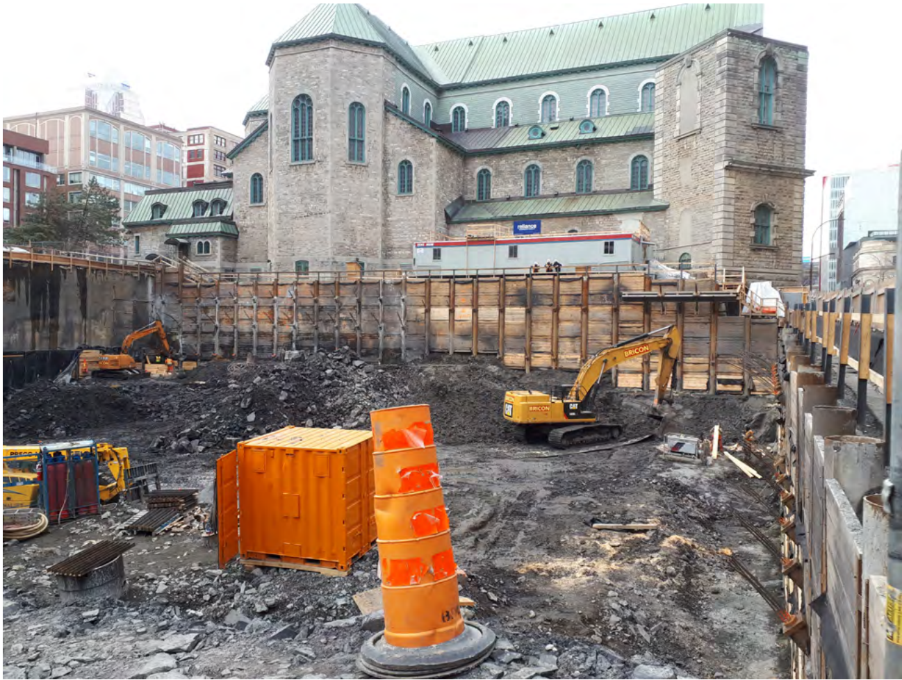
Photo montrant l'état du chantier des tours d'habitation en construction sur le site de l'ancien collège, prise le 19 mars 2020.
