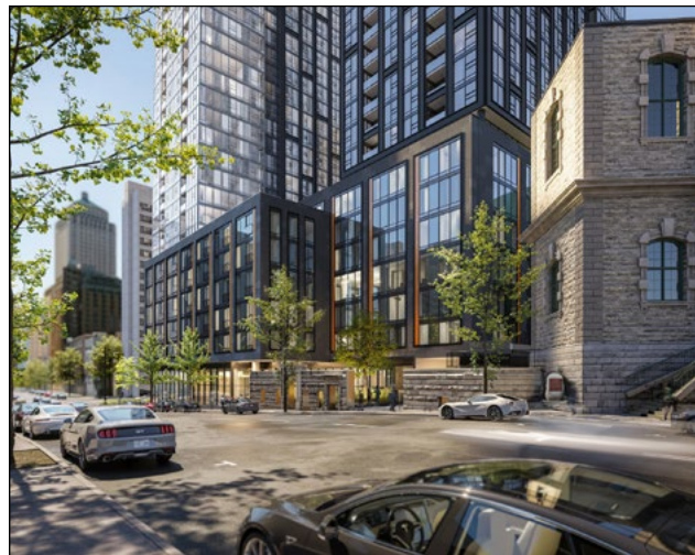
Vue nord-sud, montrant la partie du mur conservée
